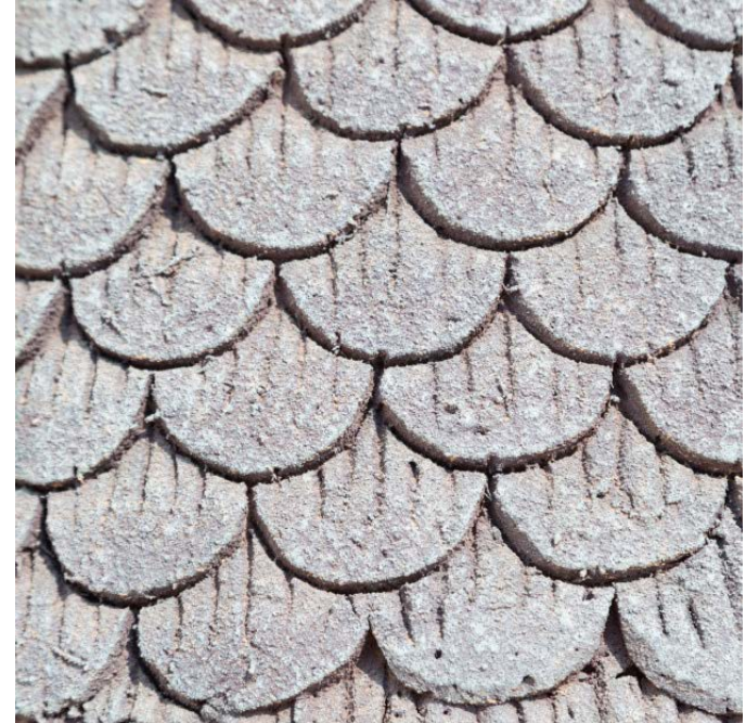
Asbestos Siding
